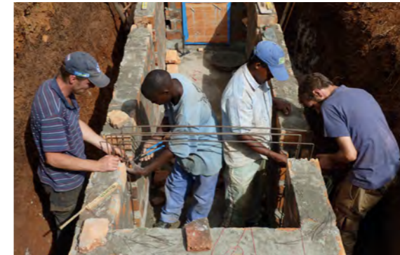
Bau einer Biogasanlage in Tansania (Teilprojektleiter Gordon Appel)
