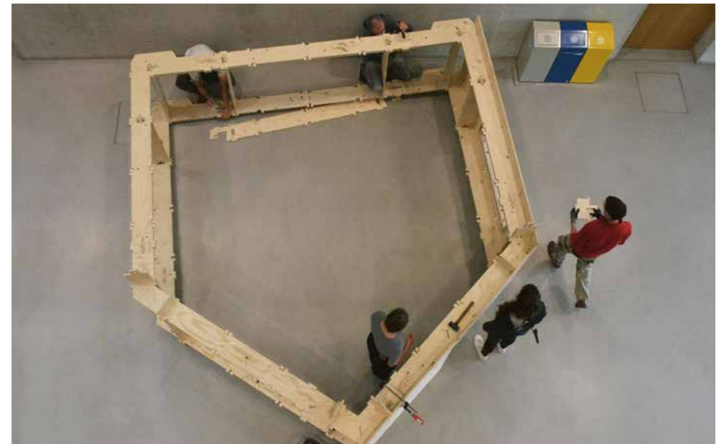
Die Bauteile des WikiHouse sind schnell zusammengesetzt.
